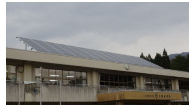
【陸前高田市竹駒小学校の太陽光発電設備】
