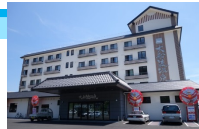
【木質バイオマスボイラーを導入した「大船渡温泉」】
