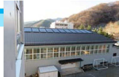
【釜石市双葉小学校の太陽光発電設備】
